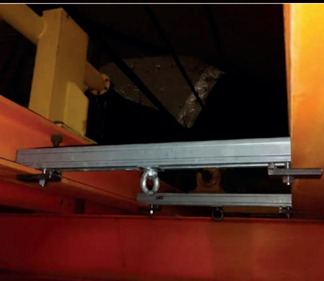
Die Befestigung von Konstruktionsteilen mit Klemmen stellt eine mögliche Schwachstelle im Brandschutz dar
