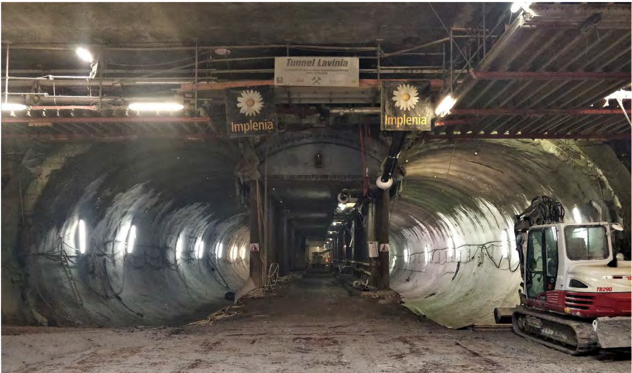
Bild 8: Vortriebsarbeiten beendet und Tunnel beräumt © Torsten Brenner
