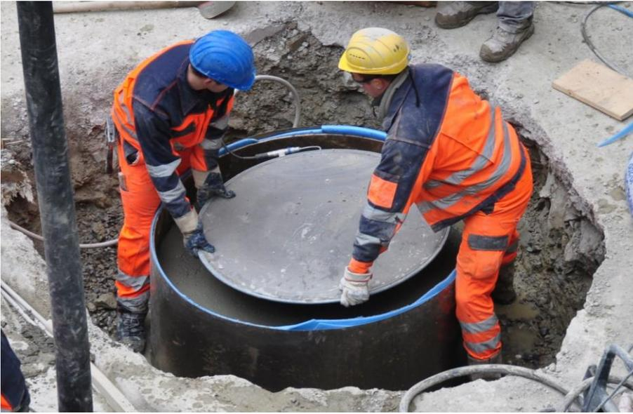
**Bild 10: Einbau einer Kraftmessdose am Kopf eines Fundationspfahls**
