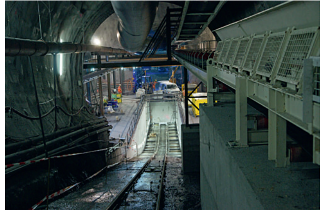
11 Baustellenbahnhof in der Kaverne Talstation
