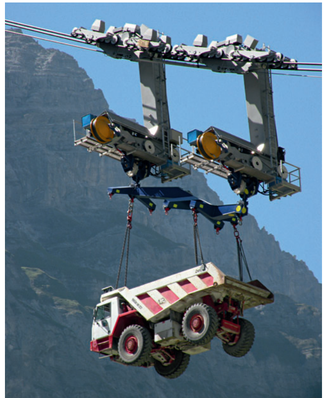
3 Transport Dumper mit der Bauseilbahn 1
