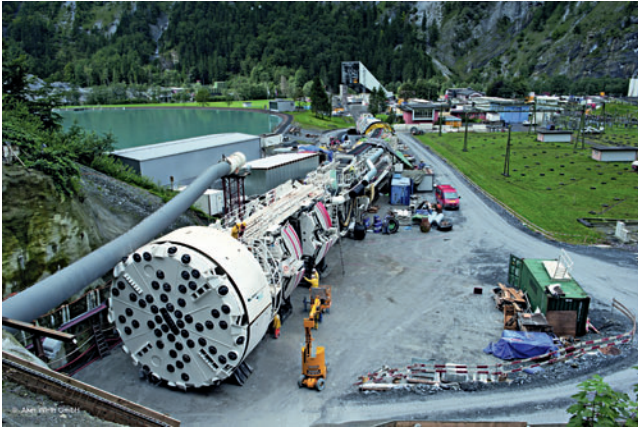
10 Fertig montierte TBM und Nachläufer vor Portal
