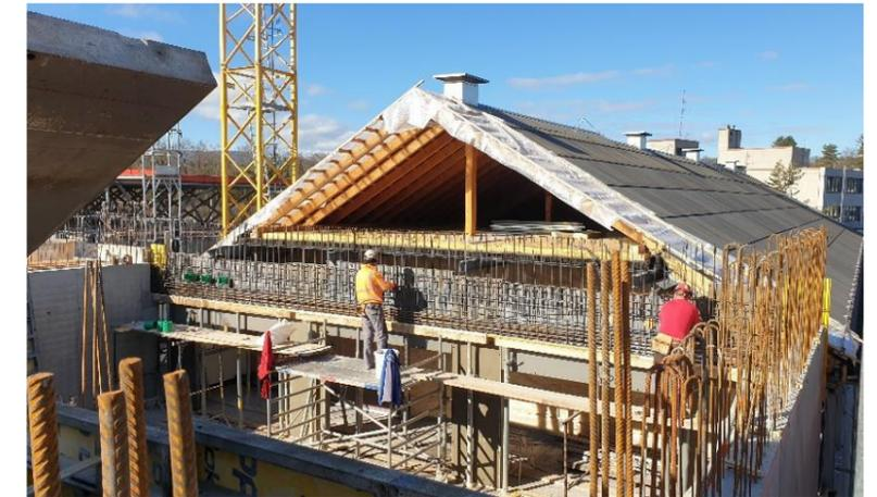
Abb. 4: Erstellen der 1. Bewehrungsetappe für die Wandscheibe in Axe 9.5 im 2.OG im Übergang zum bestehenden Dachgeschoss
