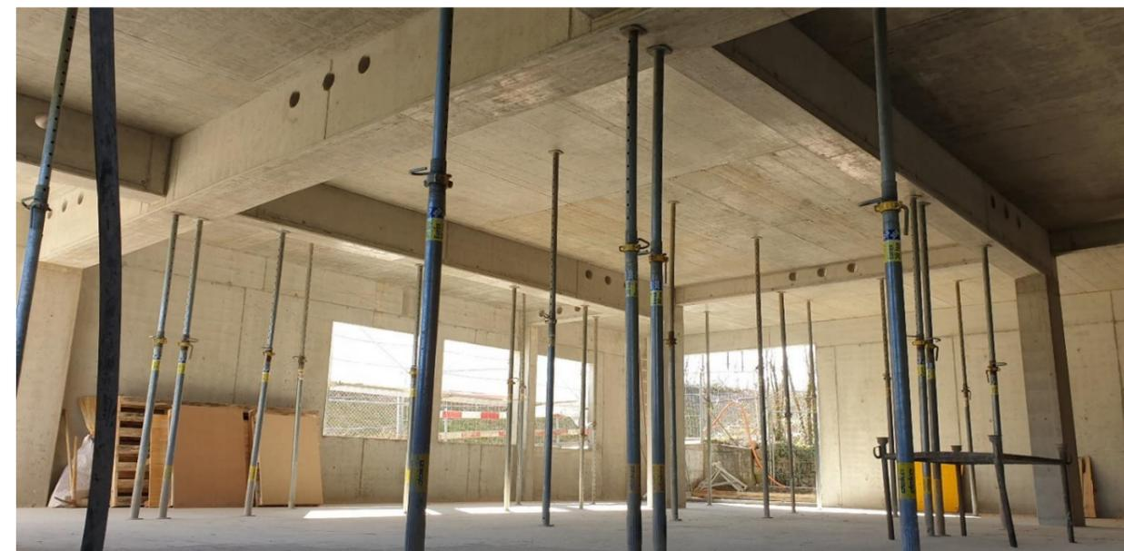
Abb.3: Decke über 1. Untergeschoss, stützenfreie Unterzugsdecke mit Spannweite von 12 x 13 m und Nutzlast von 1'200 kg/m<sup>2</sup> im EG
