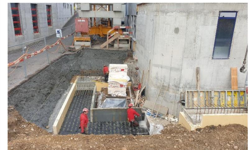
Abb. 6: Baugrube Liftunterfahrt und Unterfangung des bestehenden Gebäudes
