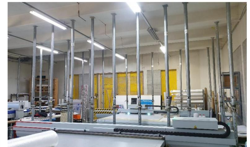
Abb. 5: Spriessung im Bestand zur Aufnahme der Spriesslasten beim Betonieren des überkragenden Anbaus im 2. Obergeschoss
