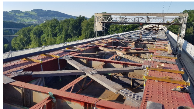
Verstärkungsarbeiten Stahlbau
