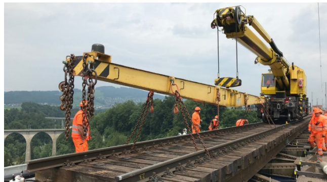
Rückbau best. Fahrbahn
