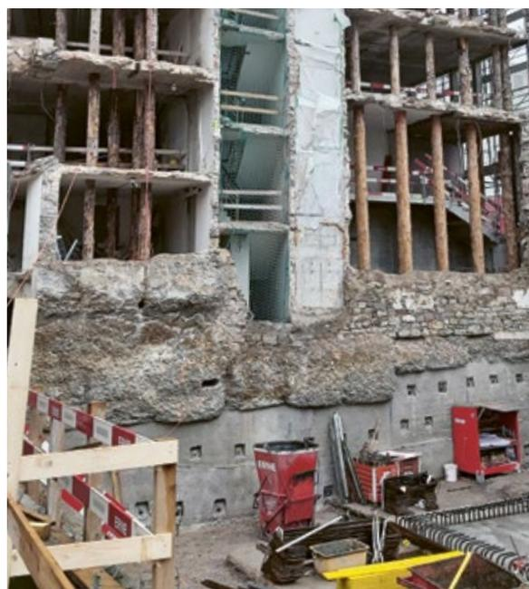
Pour le démantèlement et la démolition du bâtiment d'angle, des troncs d'arbre ont servi d'étais.
