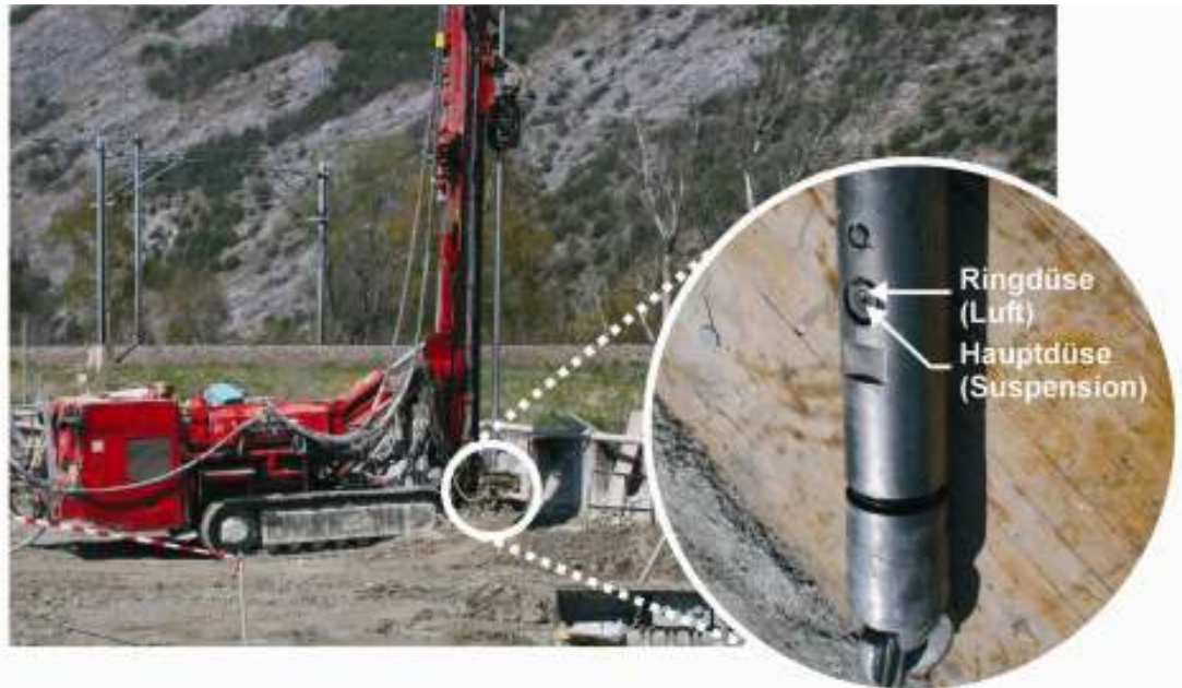
Abb. 1.14 Jettinggerät, Düsenkopf (2-Phasen Verfahren)
