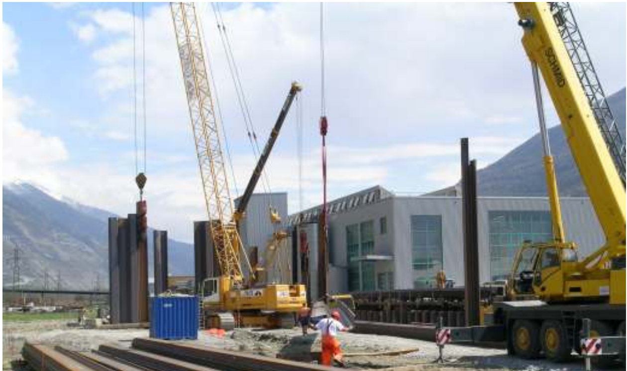
Abb. 1.23 Industriehalle der Vaparoid im Hintergrund während der Spundwandarbeiten der Baugrube Pumpwerk
