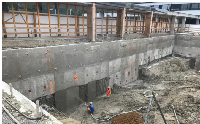
Aushub und Erstellung der Nagelwand
