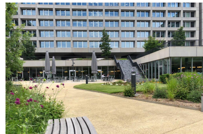
Ansicht vom Innenhof an das Gebäude 1007
