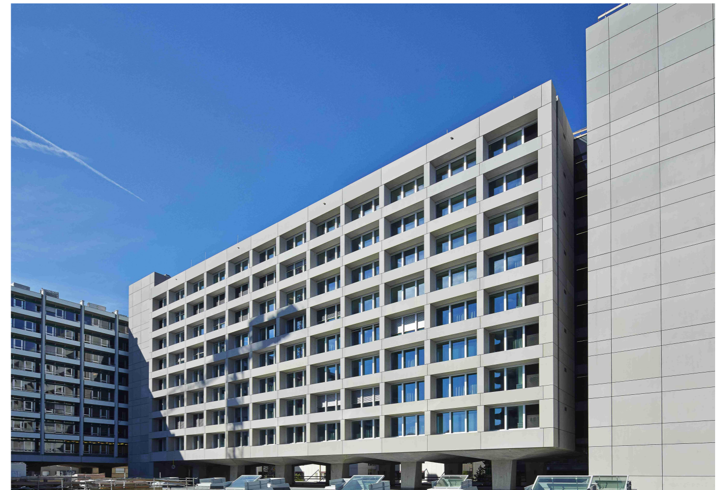
Ansicht vom Innenhof an das Gebäude 1007
