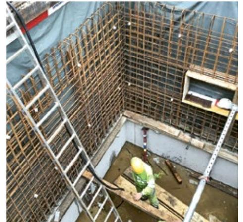
Im Bereich von Leitungsverteilungen werden bei Fernwärmeleitungen sogenannte Sektionierungsbauwerke erstellt. In diesen befinden sich Armaturen als Schieber zum Absperrern von Leitungsabschnitten und je nach Bedarf für Entleerungen/Entlüftungen. Die Baugrube wurde mittels Stahlprofilen und Stahlträgern erstellt. Erkennbar sind auch die Ausfachungen für die später zu verlegenden Fernwärmerohre.
