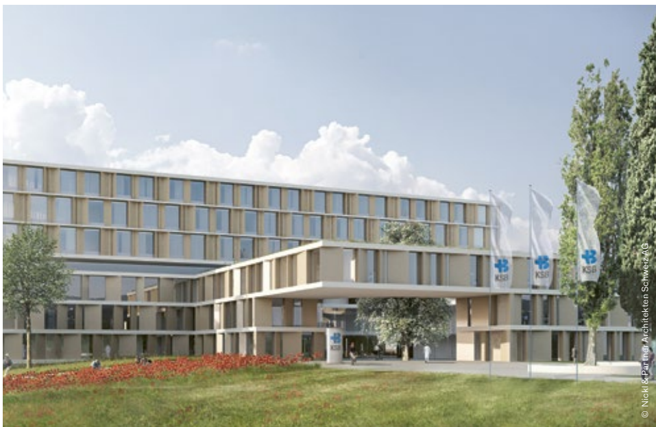
Hôpital cantonal de Baden : conseil au maître d'ouvrage, définition du concept, contrôle des mesures, accompagnement de la réalisation
