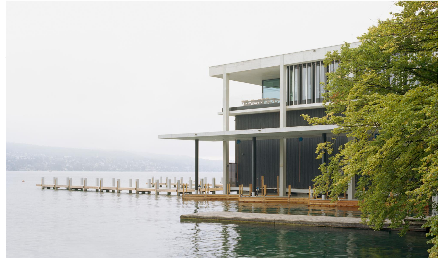
Seitenansicht mit äusseren Anlegeplätzen
