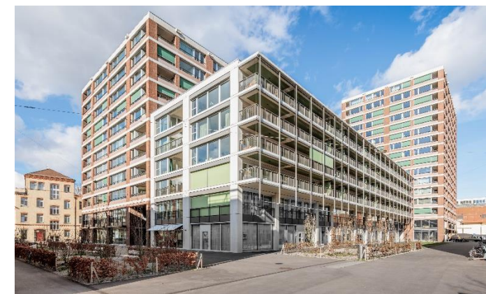
Hochhaus und Riegel Tender, im Hintergrund Hochhaus BigBoy
