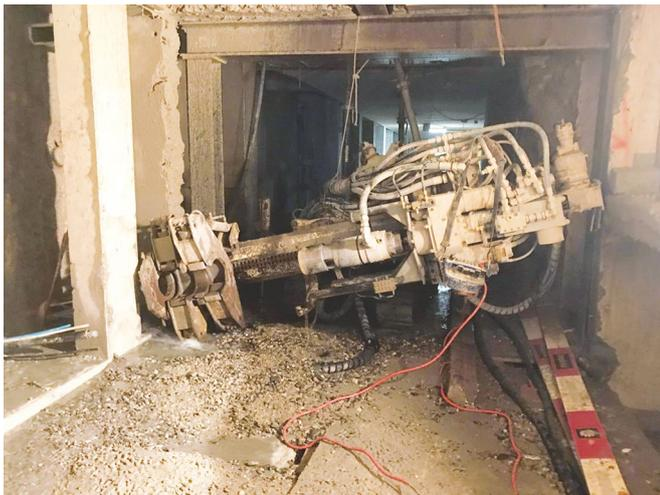
**Bild 7** Extrem beengte Platzverhältnisse bei Ankererstellung aus Bestand
