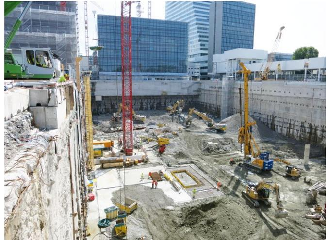
**Bild 13** Gründungsarbeiten auf der Baugrubensohle
