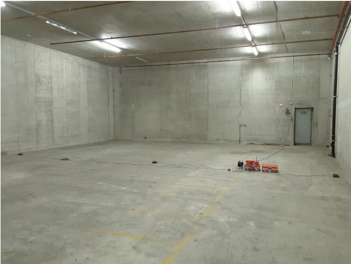
Abbildung 3 Raum der Dimension 12 \cdot 12 \cdot 6 \text{ m}^3 , wo gemessen wurde. Die Wände und Decken bestehen aus rohem Beton.
